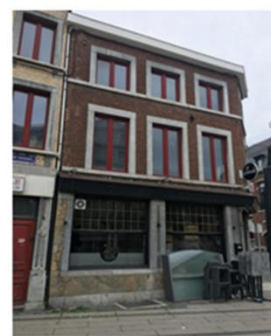
D. En bon estat, però buida
